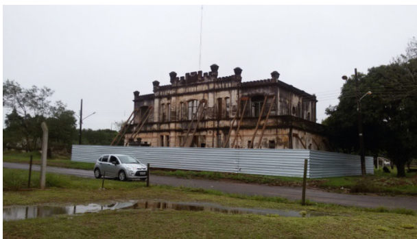
[Figura 14] – Castelinho – Tapume e Escoramento ação MPE
