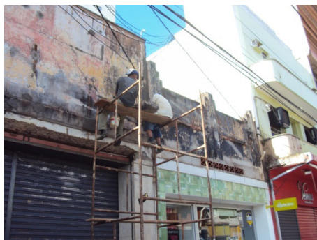
Retirada dos letreiros que encobriam as fachadas dos imóveis
