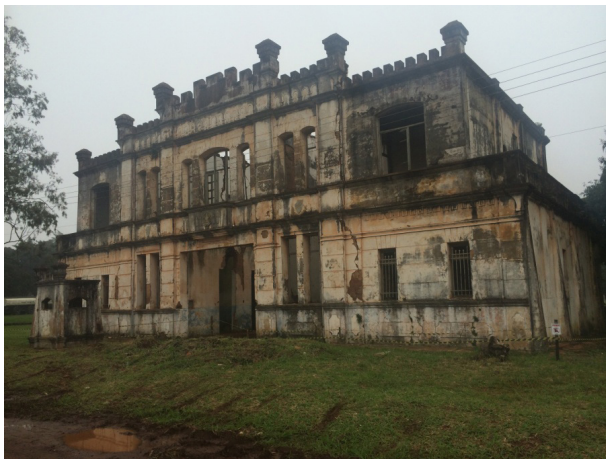
[Figura 13] Castelinho - Fachada Frontal
