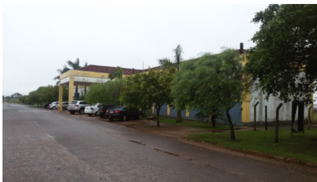
[Figura 16] Estação Ferroviária de Ponta Porã [Fonte] O autor, jun/2016
