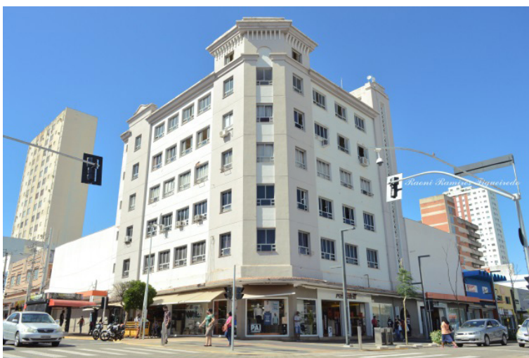
Edifício Nacao, de 1948, após obra de revitalização da Rua 14 de Julho
