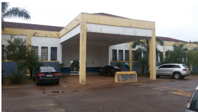
[Figura 17] Estação Ferroviária de Ponta Porã
